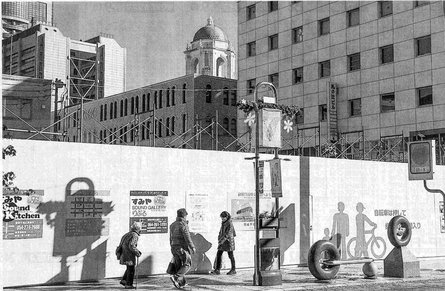
市街地再開発——県庁や市役所のすぐ近くで工事が進む。静岡市、全日写真吉川正宏さん撮影
